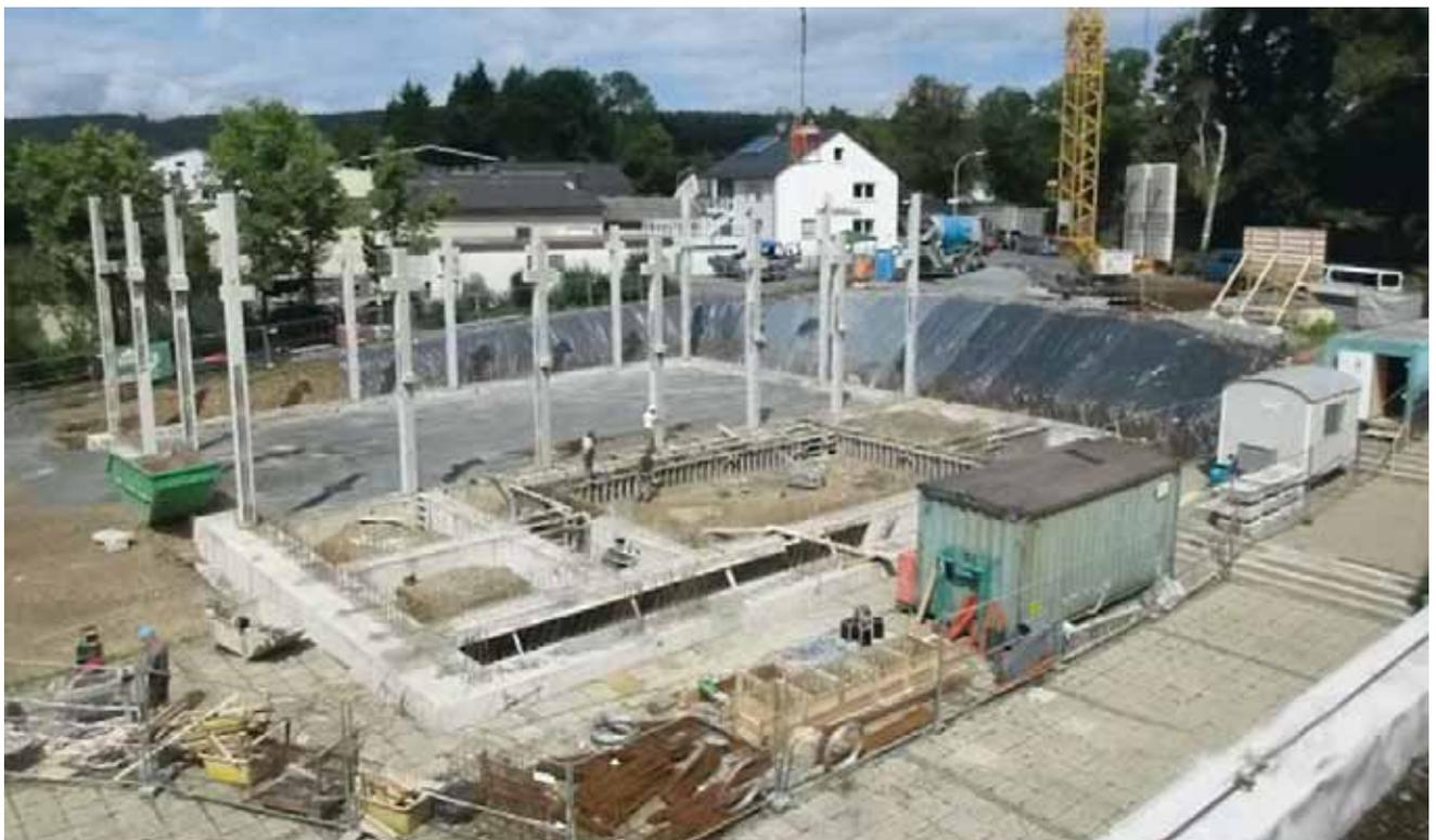
Der Neubau der Turnhalle an der Grundschule Naila geht mit großen Schritten voran. Die ersten Stahlbetonfertigteilstützen sind bereits gesetzt.
