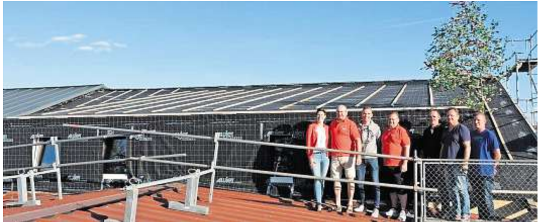
Eine kleine Birke mit bunten Bändern zeugte vom Richtfest der Dachgaube für den Jugendraum. Unser Bild zeigt vor der neu errichteten Dachgaube (von links) Bürgermeisterin Patricia Rubner, Vorsitzenden Gerhard Brühshwein, Jugendwart Maximilian Schaller, stellvertretender Kommandant Marco Kolbinger, Jugendwart Holger Wurzbacher und die unterstützenden Fachleute Jörg Ebert und Marcel Resch.
