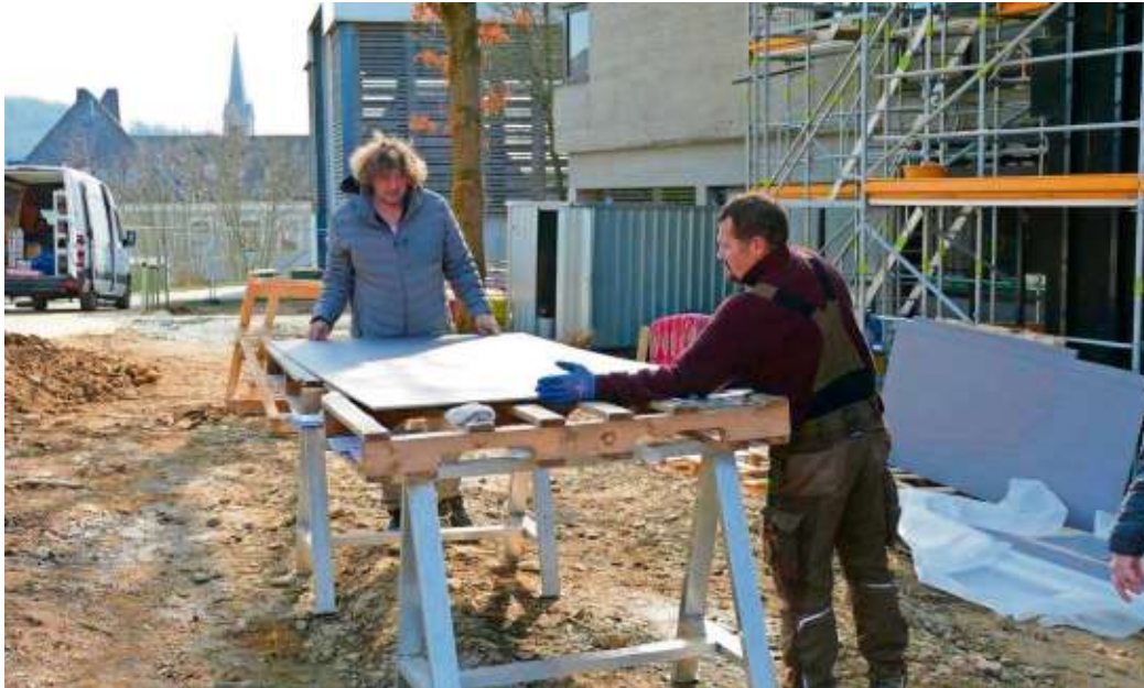
Blau, rot, grün und gelb - diese Farben in Anlehnung an das Schullogo mit der Bogenbrücke - werden an der Fassade angebracht.
