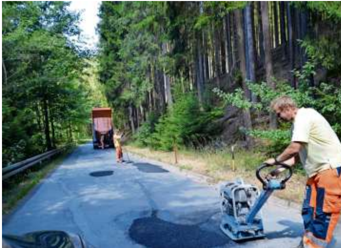
Die bisherigen Ausbesserungsarbeiten an der GV Sorg-Thiemitz.
