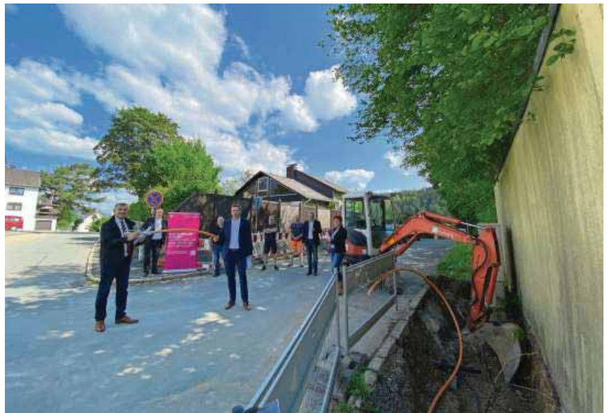
Das Foto zeigt von links: 1. Bürgermeister Frank Stumpf, Andreas Rudloff (Telekom), Andreas Ströhlein (Telekom), Maximilian Richter (Breitbandbeauftragter Stadt Naila), Henry Lauterbach (Geschäftsführer Firma Tief- und Fernmeldebau GmbH & Co. KG Uhlstädt-Kirchhasel), Angelo Will (Mitarbeiter Firma Tief- und Fernmeldebau GmbH & Co. KG Uhlstädt-Kirchhasel), Friedrich Weinlein (Telekom), und Sonja Pößnecker (Stadtbauamt Naila).
