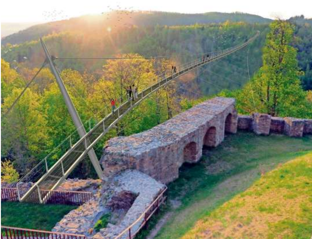
Die längste Hängebrücke der Welt entsteht im Frankenwald. Sowohl die Lohbachtal- als auch die Höllentalbrücke verlaufen leicht S-förmig. Hier eine Visualisierung der Lohbachtalbrücke.
