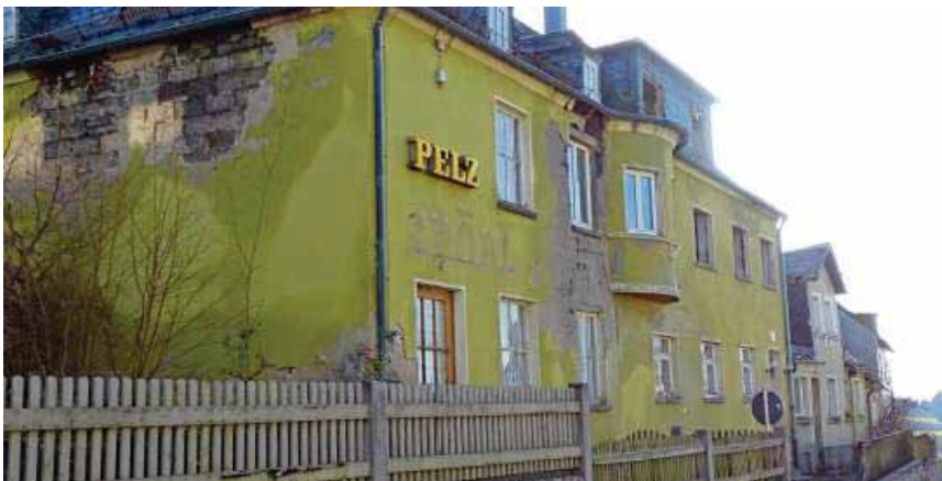
Gebäude Pelz-Spörl kurz vor dem Abriss.
