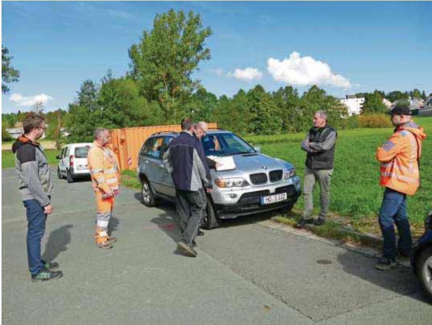
Mit einer Detailbesprechung erfolgte der Baustart zur Erneuerung der maroden Wasserleitungen in Zollstraße und Birkenweg. Das Foto zeigt Bürgermeister Dieter Gemeinhardt, Projektleiter der Helmbrechtser Firma LuK Andreas Köbrich, Bauleiter der Hofer Firma SBG Tiefbau GmbH Gunther Simon und Polier Andreas Lüttig, Reinhardt Fröh vom zuständigen Planungsbüro Schnabel aus Konradsreuth und die Firma Südwasser, vertreten durch Meister Klaus Rehm.
