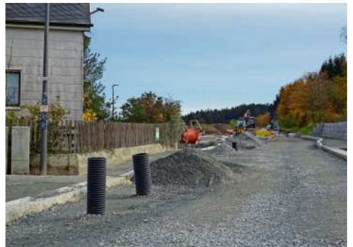
Vorbereitung Asphaltierung
