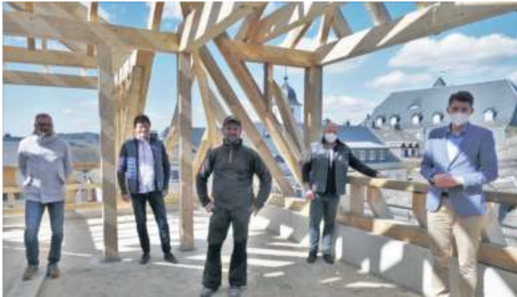
Das Foto zeigt über den Dächern der Stadt Lichtenberg (von links) Architekt Christian Dreßel, Bauherr Martin Süß, Sven Sonntag von der gleichnamigen Zimmerei aus Zell, Hans Schneider vom gleichnamigen Bauunternehmen aus Sparneck und Bürgermeister Kristan von Waldenfels.
