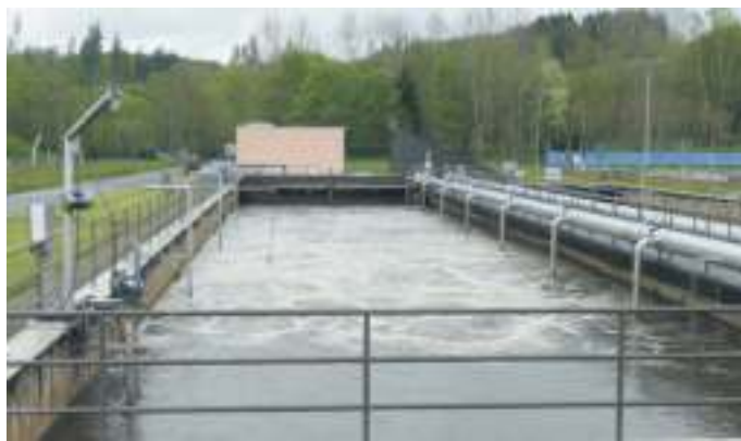
Der hohe Fremdwasseranteil in der Kläranlage soll minimiert werden und dafür plant der Abwasserverband die Schaffung einer Kanalabteilung.
