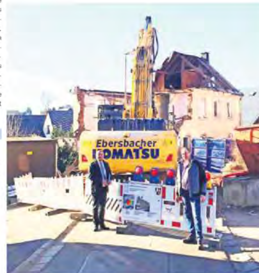
Das Foto zeigt 1. Bürgermeister Frank Stumpf und Harald Ernst vom Bauamt Naila auf der Baustelle in Marlesreuth.
