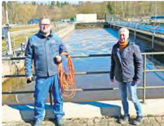
Das „tägliche Geschäft“ wird auf Anlage des Abwasserverbandes Selbitztal in Mittelklingensporn geklärt. Neu ist die Kanalabteilung seit Beginn des Jahres. Unser Bild zeigt Mitarbeiter Klaus Einsiedel und Geschäftsführerin Barbara Denzler am Becken der biologischen Reinigungsstufe.
