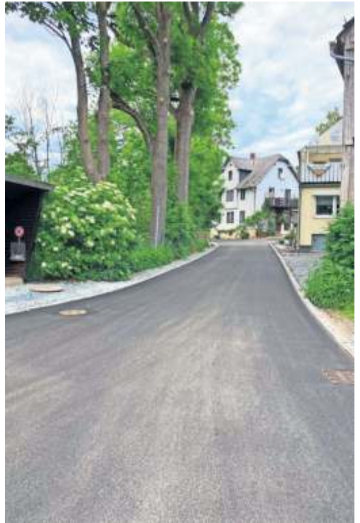
Das Bild zeigt den Straßenbau „An der Schmiede“ in Gottsmannsgrün.
