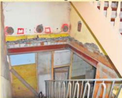
Einbau von Abfangstahlträgern
