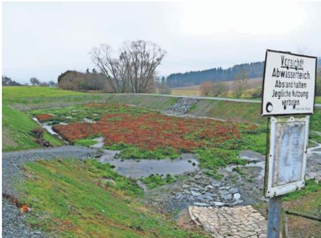
Unser Bild zeigt den ehemaligen Klärteich, der jetzt als Regenrückhaltebecken fungiert unterhalb von Schnarchenreuth in Richtung Gottsmannsgrün liegt.
