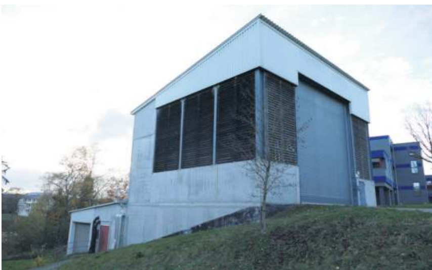
Das Hackschnitzelwerk der Stadt Naila.
