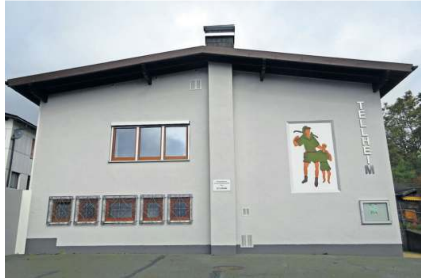
Gebäude „Badstraße 2 a“
